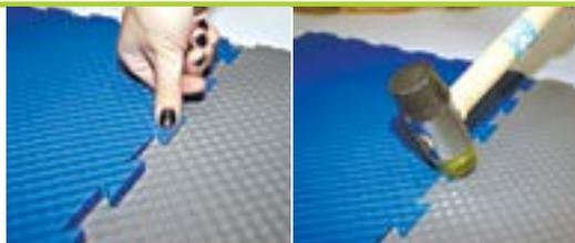
6. Покрытие рекомендуется приклеивать к основанию **сплошным нанесением клея**, если возможны большие перепады температур, на наклонных поверхностях, либо в помещении, где будет производиться интенсивное движение тяжелой техники. При сплошной приклейке состав наносится на основание пола при помощи шпателя, покрывая всю поверхность.
